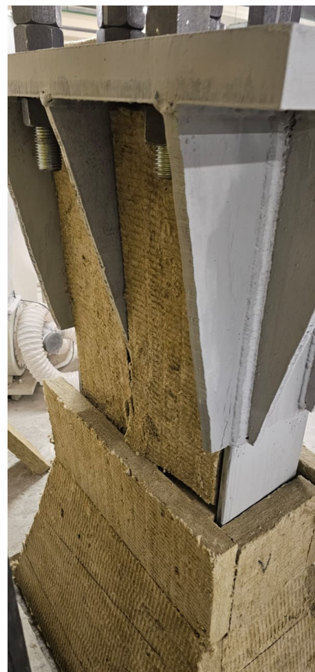
Огнезащита стоек плитами ROCKWOOL SL 150 (плиты потом можно оштукатурить по стеклосетке и покрасить)
