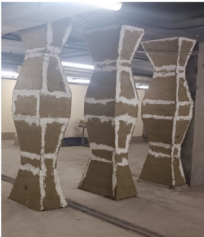
Огнезащита стоек плитами ROCKWOOL SL 150 (плиты потом можно оштукатурить по стеклосетке и покрасить)
